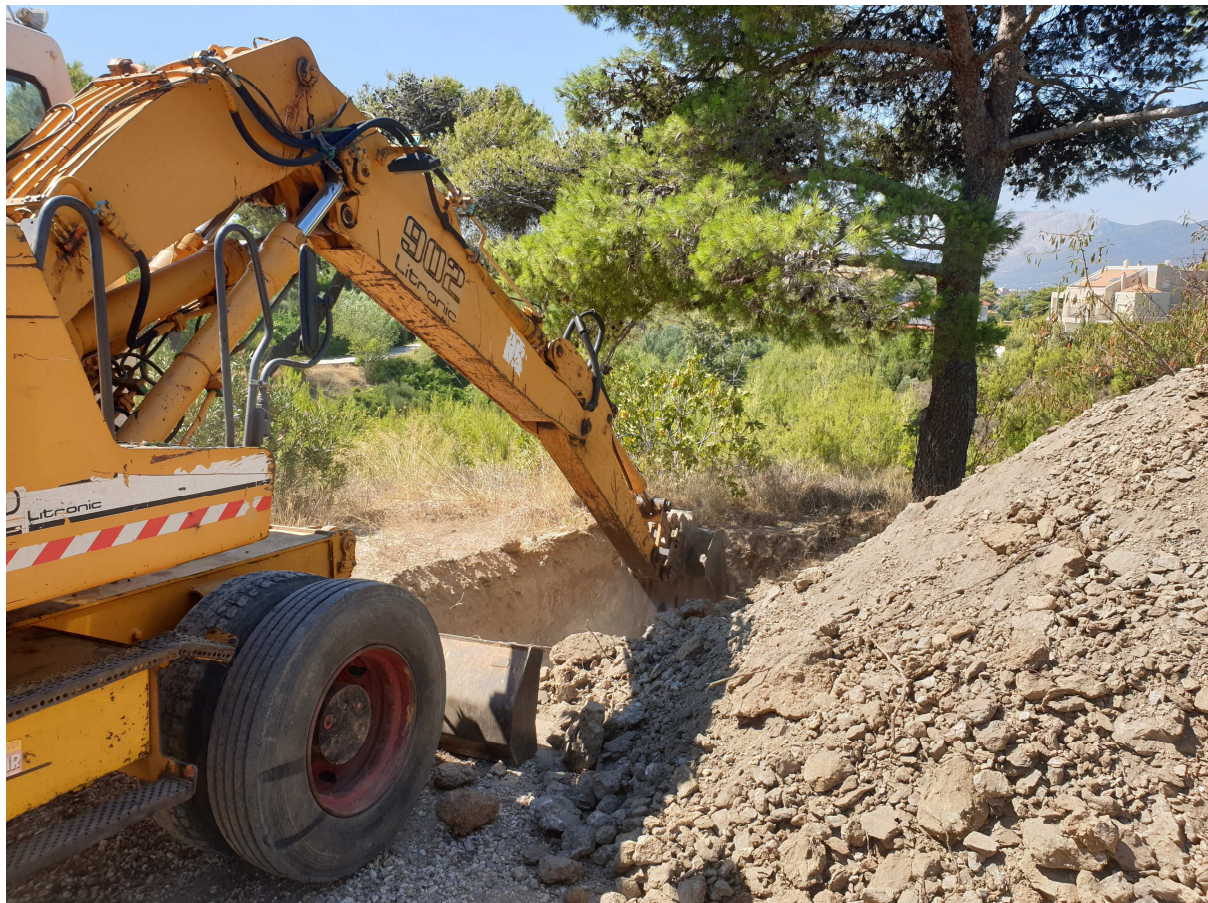
Εικόνα 5. Περιοχή διάνοιξης ερευνητικού φρεατίου (θέση αντλιοστασίου ΚΠ3).
