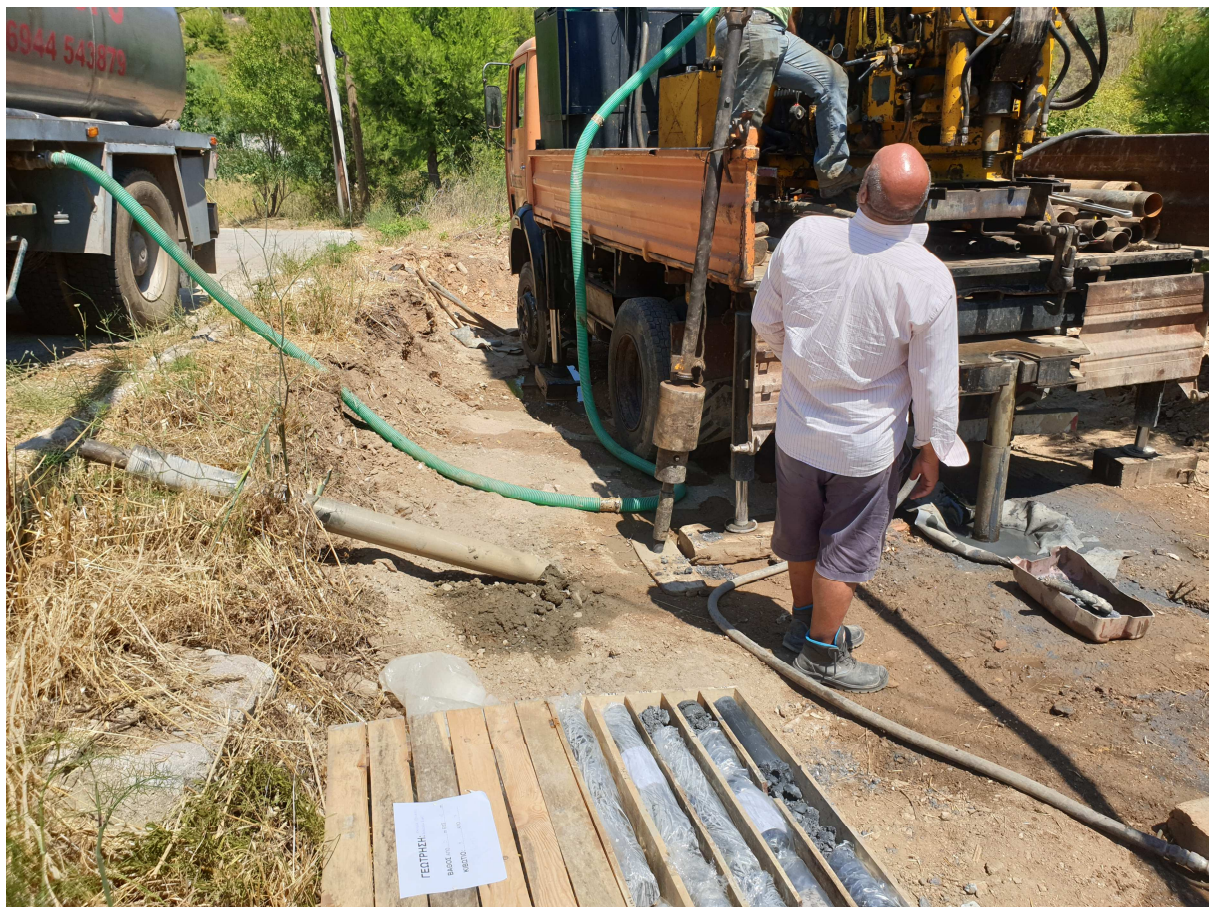
Εικόνα 1. Θέση διάνοιξης δειγματοληπτικής γεώτρησης (θέση αντλιοστασίου ΚΠ2)
